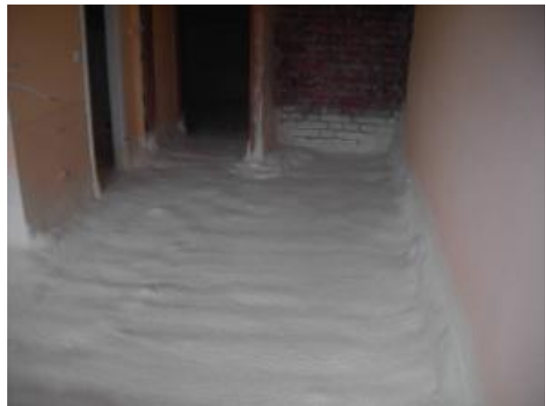
Notverschäumung
