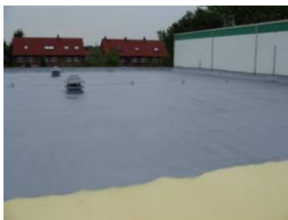
geschäumt und größter Teil mit UV-Schutz
