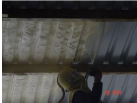
Verschäumung Unterdach einer Halle
