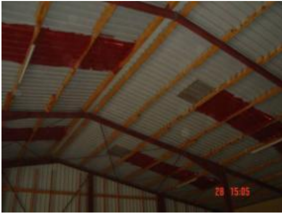
Lichtbänder von innen mit UV-Schutz
