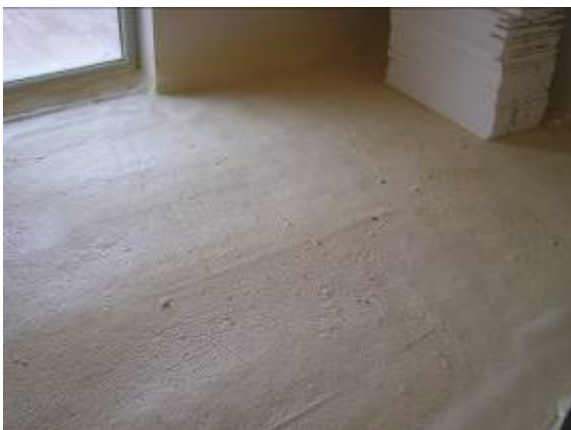
Fußbodenverschämung für Estrich
