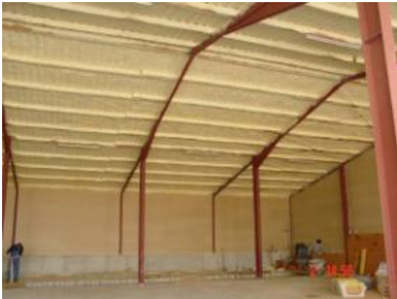
Unterdachverschäumung einer Halle
