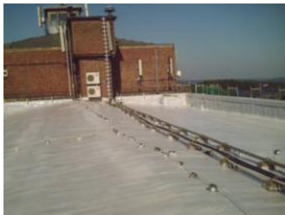
geschäumtes Industriedach mit UV-Schutz
