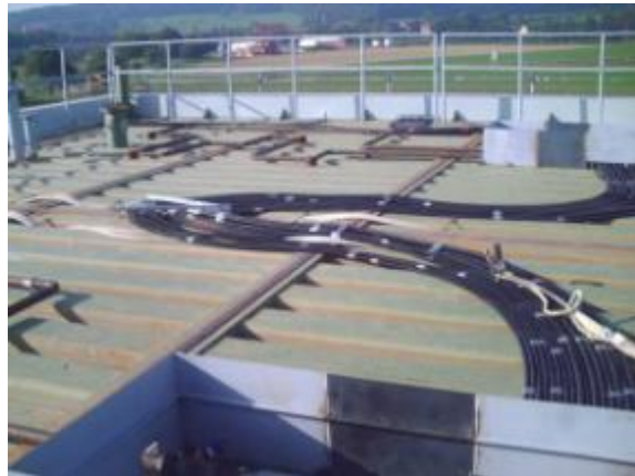
Faulturm vor Dachbeschichtung
