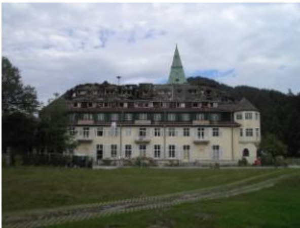
Notverschäumung wegen Löschwasser
