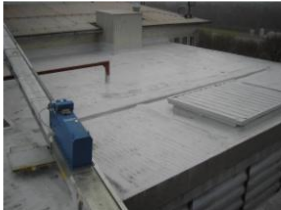
mit OSB-Platten neu belegt
