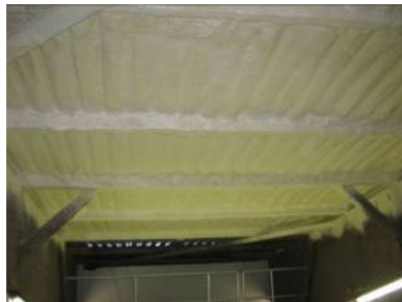
Unterdachverschämung einer Halle
