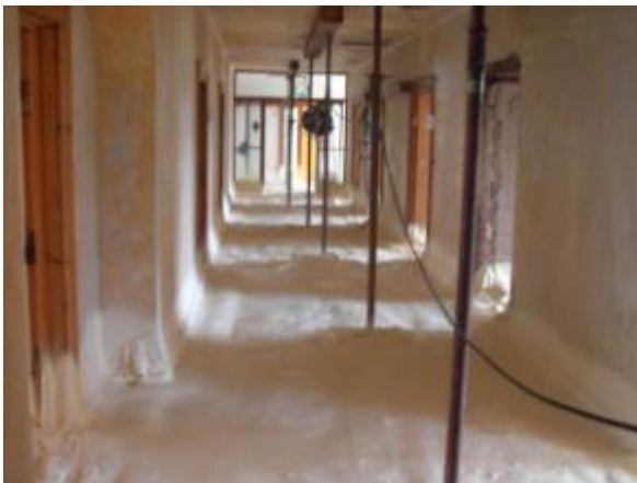
Notverschäumung
