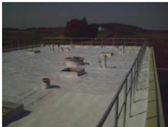
fertig beschichtetes Dach
