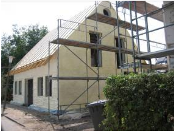
Wanddämmung vor Klinker
