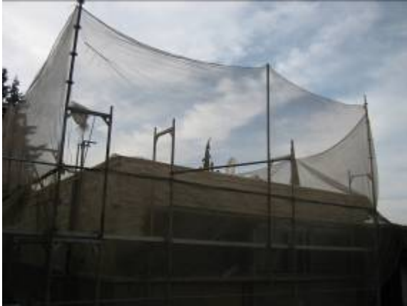
Einrüstung und Staubschutznetz
