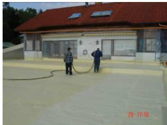
Tiefgargendach für Dachbegrünung
