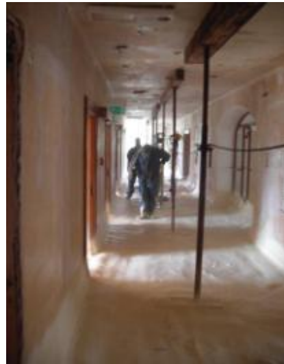
Notverschäumung
