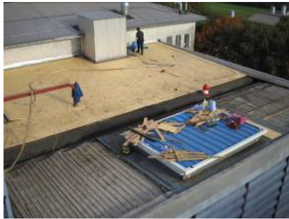
mit OSB-Platten neu belegt
