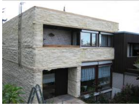
Wanddämmung vor Holzverkleidung
