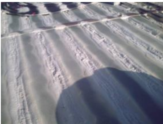
Fugenverfüllung aufdach bei einem Faulturm
