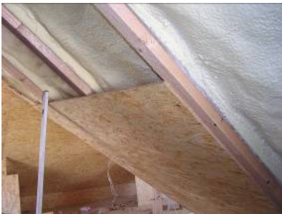
Unterdachverschämung im Neubau
