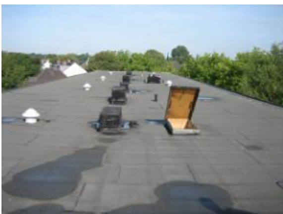
Mehrfamilienhaus Duisburg vorher
