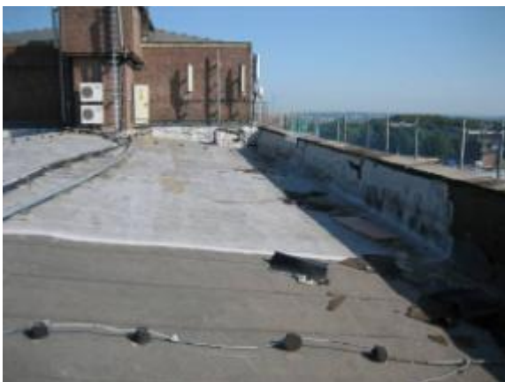
Altes teilgeschäumtes Industriedach
