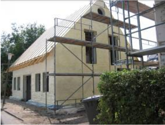
Wanddämmung vor Klinker
