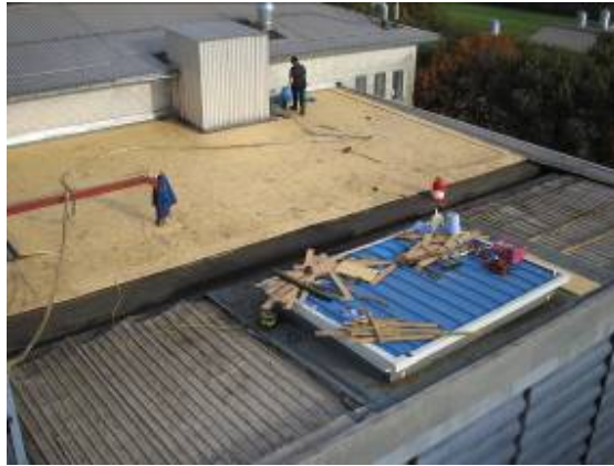
mit OSB-Platten belegt
