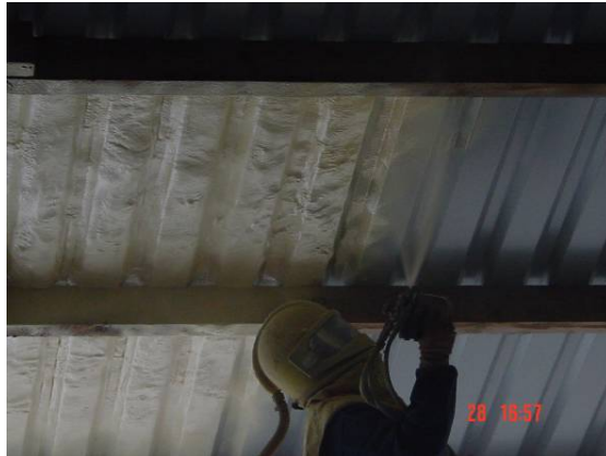
Verschäumung Unterdach in einer Halle
