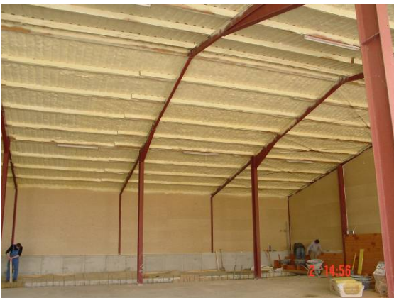
Unterdachverschäumung einer Halle
