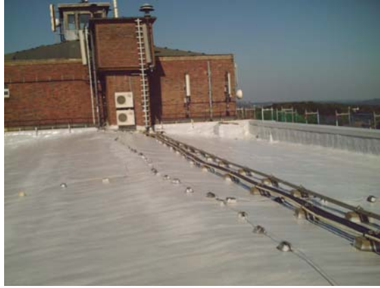
geschäumtes Industriedach mit UV-Schutz
