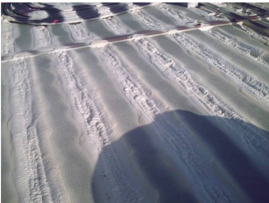
Fugenverfüllung aufdach bei einem Faulturm
