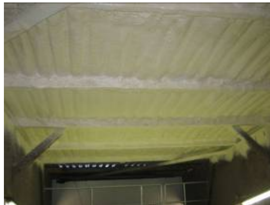
Unterdachverschäumung von einer Halle
