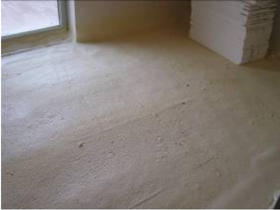
Fußbodenverschäumung für Estrich
