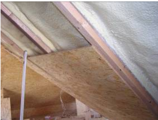
Unterdachverschäumung im Neubau
