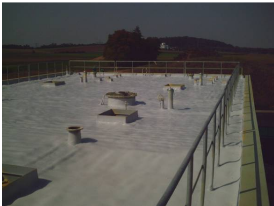
fertig beschichtetes Dach
