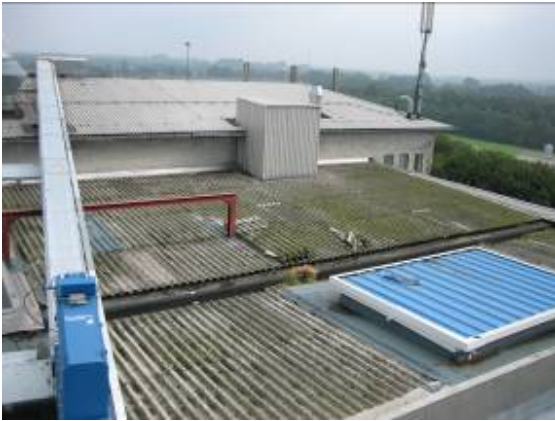
Asbestdach vor Beschichtung
