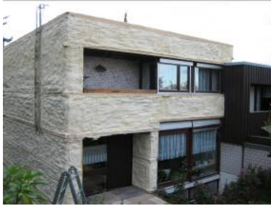
Wanddämmung vor Holzverkleidung
