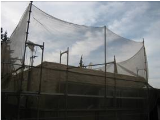
Einrüstung und Staubschutznetz
