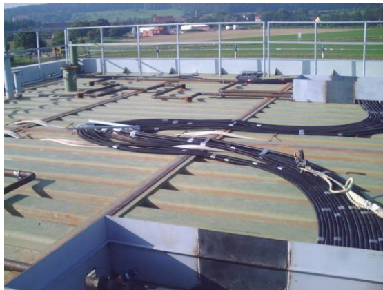
Faulturm vor Dachbeschichtung
