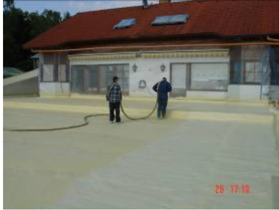
Tiefgaragendach für Dachbegrünung
