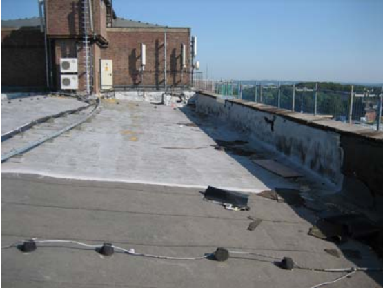
Altes teilgeschäumtes Industriedach
